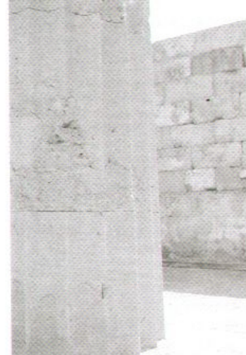
FIGURE 49-50 • Selinunte (Trapani). Il tempio E, dettagli del colonnato con integrazioni in cemento. Sacro a Hera, è il più meridionale dei tre templi che sorgono sulla collina orientale. Esso assume la sua forma definitiva e compiuta negli anni 460-450 a. C. I suoi elementi furono in gran parte rimontati mediante operazione di anastilosi e di reintegrazione che è stata prima fortemente contrastata, poi molto criticata sia per aver mutato notevolmente un suggestivo ambiente archeologico che per le modalità di esecuzione e per i materiali impiegati. L'intervento, approvato nel 1955, è stato progettato e diretto negli anni successivi da Jole Bavia Marconi ed è stato eseguito con la consulenza della direzione generale e del Consiglio superiore delle antichità e belle arti. I lavori sono consistiti nella sistemazione degli elementi del tempio recuperati e ordinati, nella reintegrazione in conglomerato cementizio armato di alcune parti mancanti, peraltro eseguita con indubbia perizia.
