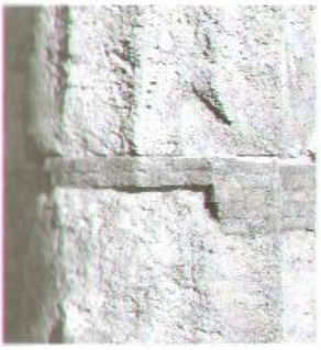
FIGURE 47-48 • Selinunte (Trapani). I resti del tempio C (di Apollo?), dopo l'anastilosi e dettaglio di una colonna con integrazione in laterizi. Il tempio periptero esastilo, databile intorno alla metà del VI secolo, secondo alcuni sorge sui resti di un tempio arcaico. Nel 1925-27 Francesco Valenti rialza dodici colonne del lato nord, complete di capitelli e di alcuni tratti di trabeazione e integra con laterizi le parti mancanti. Nel secondo dopoguerra la Soprintendenza archeologica di Palermo effettua un intervento di consolidamento che è consistito nell'inserimento di grappe di ottone, immerse in un conglomerato cementizio.
