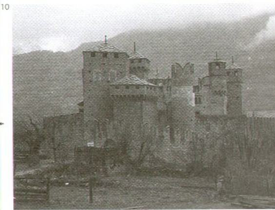
FIGURE 9-10 • Fénis (Aosta). Il castello, veduta d'insieme, planimetria e pianta del piano terreno. Il primo corpo di fabbrica - probabilmente una "torre castellata" (XII secolo) - viene integrato dalle strutture trecentesche che ne definiscono il nucleo centrale pentagonale e le due cinte murarie concentriche. Nel XV secolo, con l'inserimento di elementi decorativi (finestre, camini, affreschi ecc.), il castello viene adeguato ad una funzione più residenziale. Alfredo D'Andrade, dopo aver operato attivamente per acquisirlo allo Stato (1895), interviene con un cauto restauro, per lo più limitato ai lavori di consolidamento, così da arrestare il grave stato di degrado. Una serie di rilievi testimoniano lo scrupolo documentario dell'architetto il quale opera in una prospettiva sostanzialmente conservativa (1897-1920), maggiormente rilevabile se si confronta la sua opera con l'arbitrarietà dell'intervento successivo effettuato dal 1935 (da Zanotto, 1979, AA.VV., 1981b).
