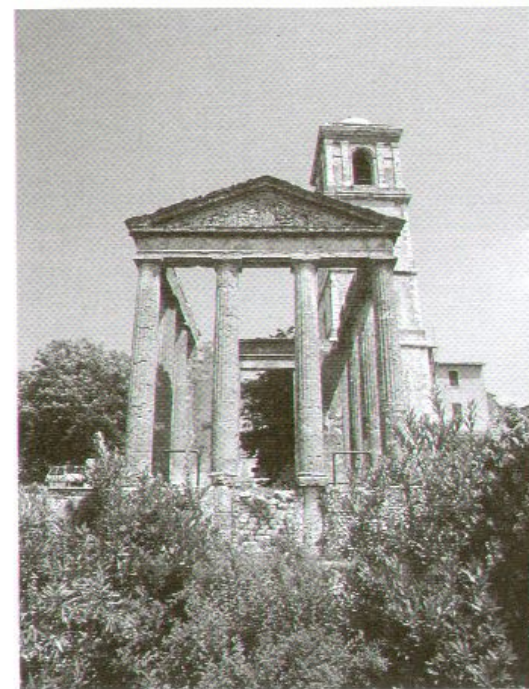
FIG. 12-13 • Cori (Latina). Il tempio di Ercole in una tavola di rilievo di Antonio da Sangallo il Giovane (dis. Uffizi Arch. 1165v) e veduta attuale. Si tratta di un tempio a podio disposto nel senso nord sud, dorico tetrastilo protilo: i cui caratteri stilistici hanno indotto a collocarlo in epoca sillana (138-78 a. C.). Come testimonia anche il disegno sangallesco, esso diventa oggetto di un costante interesse fin dal XVI secolo: lo studiano Winckelmann, Piranesi, Fea, Canina e molti altri. Oggi si conservano ancora le parti interne del podio, la parete della cella con i muri longitudinali, nonché il pronao riempito di otto colonne, trabeazione e frontone. Anche Giovannoni si occupa del tempio: in un primo momento studia la curvatura delle linee; successivamente, passo alla sua "liberazione". Un tema peraltro affrontato già negli anni venti del secolo scorso e che si ripropone più volte all'attenzione degli studiosi. L'intento è quello di liberare la cella occupata dal campanile e occlusa dalla parete della chiesa di San Pietro annessa al lato occidentale del tempio. Così, oltre a liberare il campanile, si pensa di creare un vestibolo alla chiesa riordinando il prospetto. Vengono elaborati vari progetti (1866, 1899-1902), tuttavia l'isolamento si limita a rendere libera la cella rifondando il podio con elementi in laterizio.
