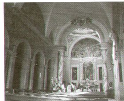
FIGURA 3 • Roma, Santa Pudenziana, veduta interna. La "ristrutturazione", che si inizia nel 1588, segue la strada dell'"aggiornamento"; le colonne sono racchiuse in nuovi sostegni murari e la canca dell'abside viene tagliata per realizzare la cupola (Francesco da Volterra, 1588). Ciò apporta una menomazione al mosaico (IV secolo), che perde due dei dodici apostoli.
