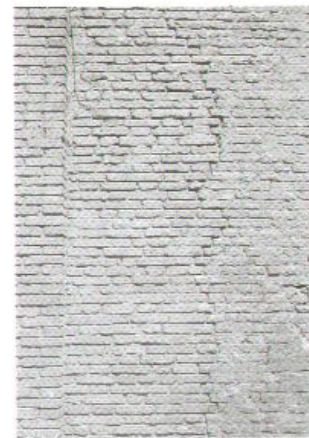
FIG. 4-5-6 • Padova. Chiesa degli Eremitani di Sant'Agostino dedicata ai santi Filippo e Giacomo, vedute interne che mostrano l'edificio prima e dopo la ricostruzione (post 1945) e dettaglio della parete esterna dell'abside che evidenzia le parti realizzate in leggero sottosquadro per distinguerle da quelle originarie salvatesi dal bombardamento. La fabbrica, costruita fra il 1276 e il 1306 in forme romanico gotiche, presenta un'ampia navata (m 80 x 19) le cui pareti, eseguite a ricorsi alterni di tufo e laterizi, sono concluse da una volta lignea; le cappelle vengono aggiunte nei secoli successivi, specialmente fra XVI e XVII secolo quando vi opera anche Bartolomeo Ammannati (mausoleo di Marco Mantova Benavides, 1546). L'interno è arricchito da una preziosa decorazione pittorica alla quale hanno lavorato molti fra i maggiori artisti dell'Italia settentrionale. Nel mese di marzo 1944 due grappoli di bombe colpiscono la facciata, la cappella Ovetari (a destra del presbiterio) con gli affreschi di Andrea Mantegna e l'abside maggiore. Pertanto, oltre alla ricostruzione delle parti cadute, si procede alla ricomposizione in loco dei lacerti pittorici recuperati, fra i quali però predominano le "zone neutre" (da AA.VV., 1950).
