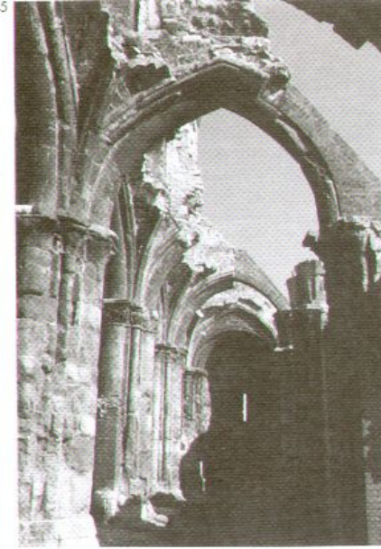
FIGURA 52-53 Zsombok (Ungheria). Abbazia premostratense, le strutture superstiti verso l'abside e sezioni arcuate della navata destra. Tutte le opere eseguite, sia il grande sperone posto a contrastare la spinta sia le aggiunte più modeste, mettono in evidenza l'intento di Möller di garantire stabilità alle parti antiche attraverso provvedimenti realizzati con muratura di laterizi che rende immediata la loro distinzione. Questo intervento, oggi giustamente tanto lodato e considerato esemplare, probabilmente è dovuto alla scarsità di mezzi che hanno imposto di rinunciare a lavori di reintegrazione così come era stato fatto per altri monumenti e si è continuato a fare anche nei decenni seguenti.
