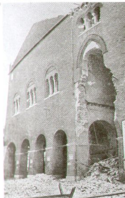
FIGURE 1-2-3 • Treviso. Palazzo dei Trecento, veduta della parete nord danneggiata dal bombardamento e dopo la ricostruzione e particolare di una zona reintegrata. Il palazzo, luogo del Maggior Consiglio del Comune composto da trecento cittadini, viene costruito a cominciare dal secondo ventennio del XIII secolo in forme romaniche, tutto in laterizio in vista. Consta di un portico parzialmente trasformato alla metà del XVI secolo e di un piano superiore costituito da un unico grande salone, che prende luce da un ordine di trifore inscritte in lunette decorate al quale si accede da una grande scala esterna. Nel 1944 il palazzo è gravemente danneggiato, infatti viene abbattuta buona parte della sala superiore che fa inclinare considerevolmente la parete nord e il tratto rimasto in piedi di quella est, a ridosso della quale è la scala di accesso al salone. Nel corso dei lavori di restauro i muri sono riportati a piombo con un ingegnoso sistema di catene e puntelli, le grandi lacune sono risarcite e reintegrate rispettando il classico postulato della distinguibilità delle parti dovute all'intervento (da AA.VV., 1950).
